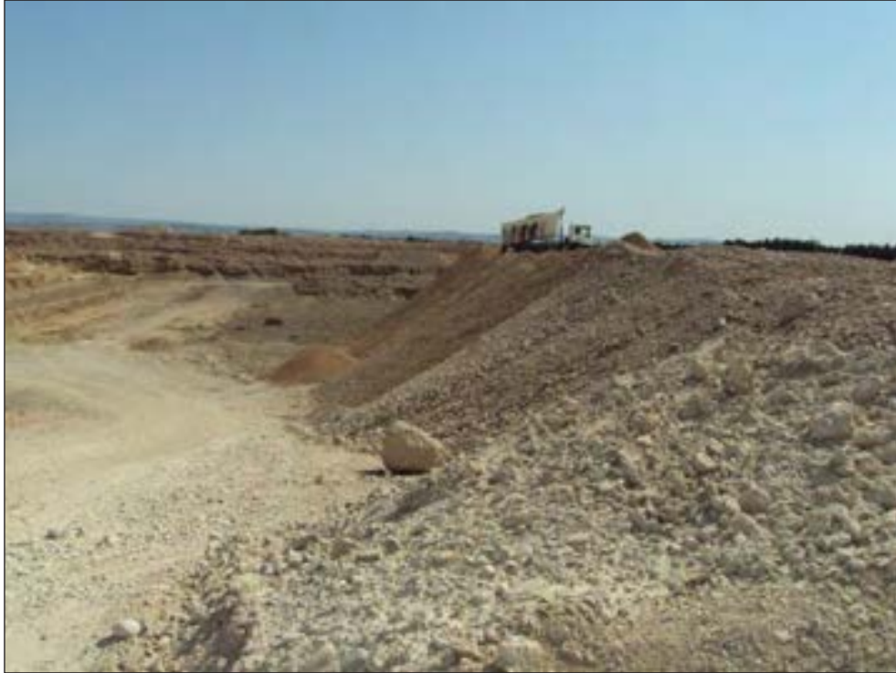
Fotografía 2.- Modelo del relleno tras la explotación hasta la cota diseñada.
